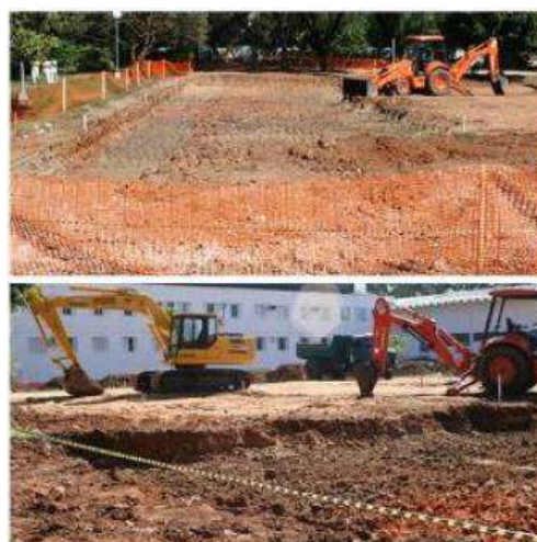
Figura IV. 2 Fase 2 Construção de Pavimento Permeável (Virgiliis, 2009)
