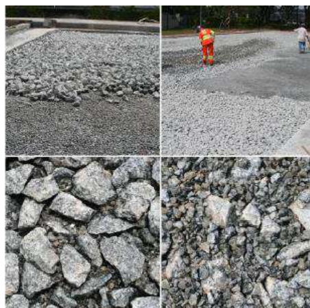
Figura IV. 10 Fase 10 Construção de Pavimento Permeável (Virgiliis, 2009)
