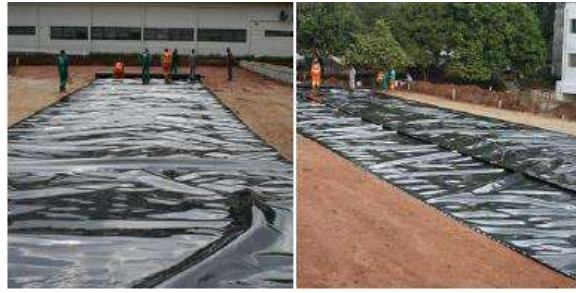
Figura IV. 5 Fase 5 Construção de Pavimento Permeável (Virgiliis, 2009)
