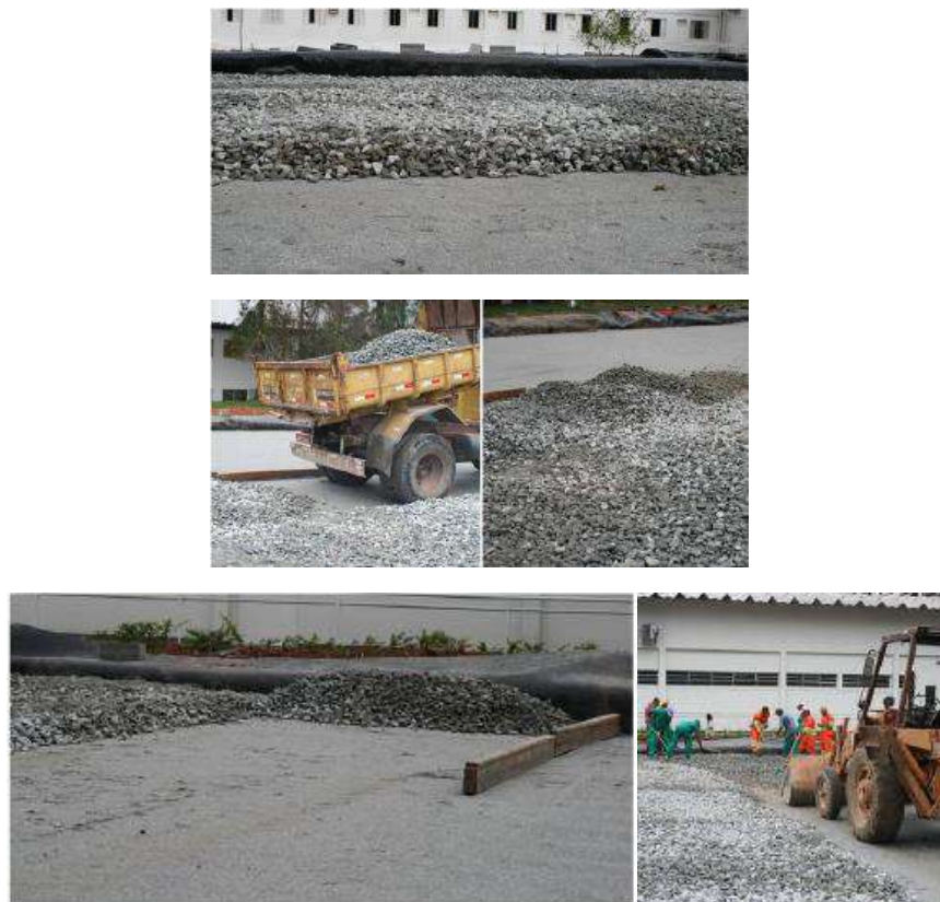
Figura IV. 6 Fase 6 Construção de Pavimento Permeável (Virgiliis, 2009)
