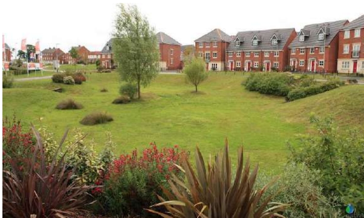
Figura 4.7 Bacia de retenção a seco (Susdrain, 2012)
