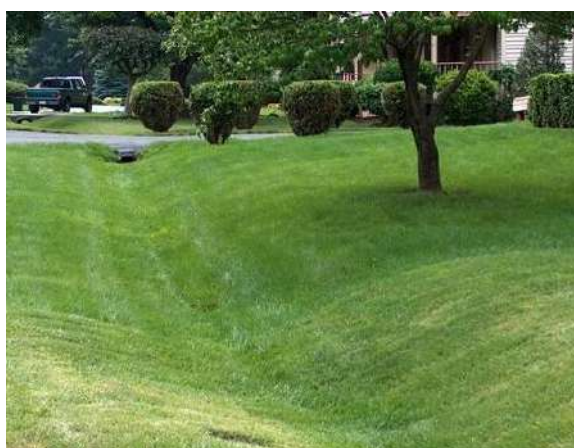
Figura 4.56 Vala relvada integrada em zona urbana (Fairfax, 2007)
