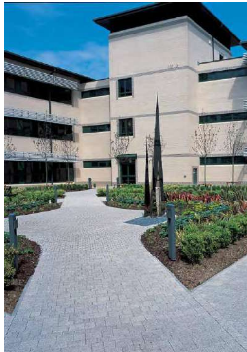
Figura 4.27 Pavimento permeável em blocos de betão (FORMPAVE, 2014)
