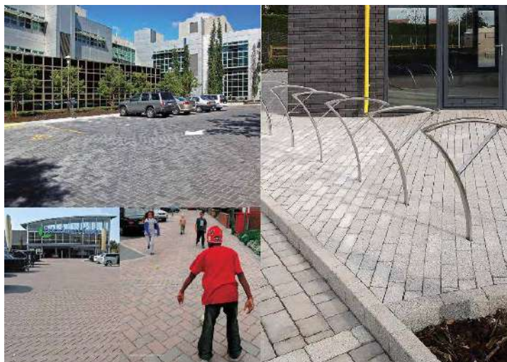
Figura 4.23 Aplicação de pavimentos permeáveis (FORMPAVE, 2014)
