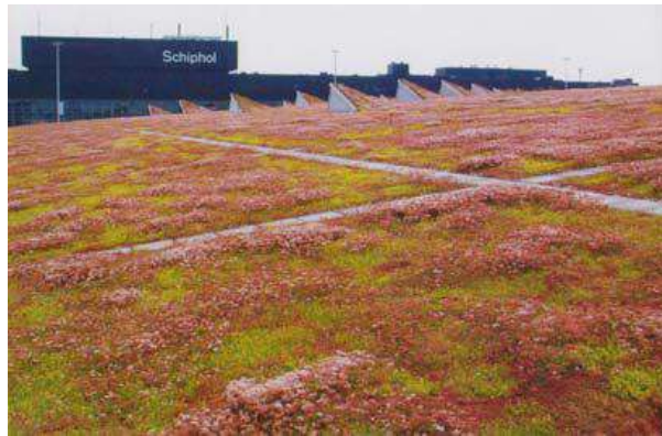
Figura 4.52 Cobertura extensiva do aeroporto de Amesterdão (Raposo, 2013)
