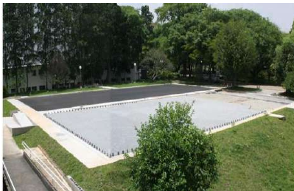
Figura IV. 15 Fase 15 Construção de Pavimento Permeável (Virgiliis, 2009)
