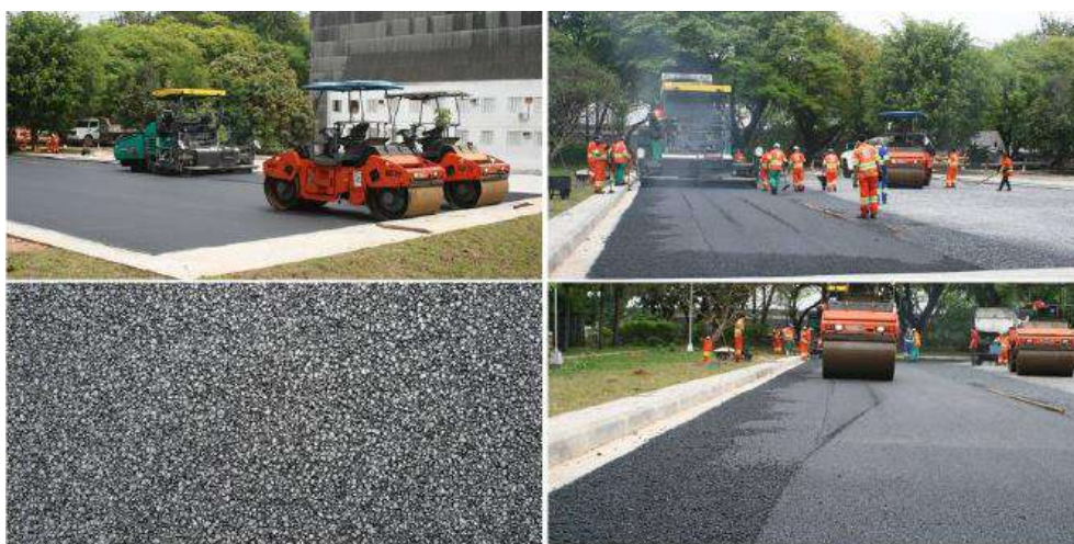
Figura IV. 12 Fase 12 Construção de Pavimento Permeável (Virgiliis, 2009)
