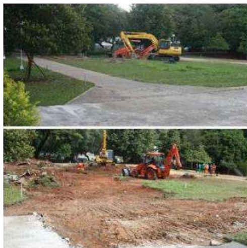
Figura IV. 1 Fase 1 Construção de Pavimento Permeável (Virgiliis, 2008)
