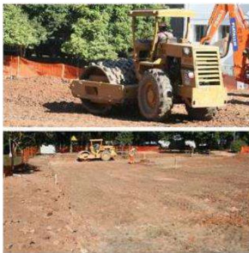
Figura IV.3 Fase 3 Construção de Pavimento Permeável (Virgiliis, 2009)
