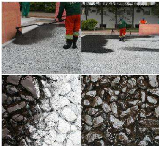
Figura IV. 11 Fase 11 Construção de Pavimento Permeável (Virgiliis, 2009)
