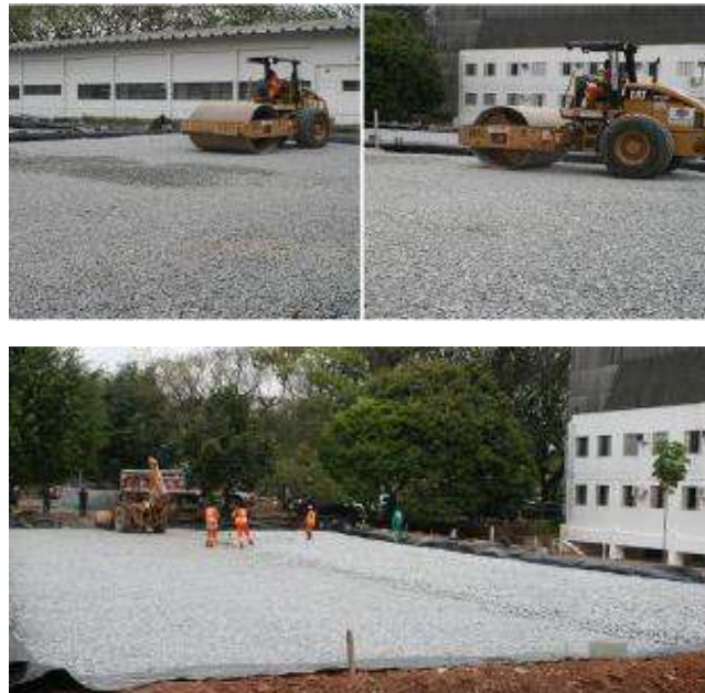
Figura IV. 7 Fase 7 Construção de Pavimento Permeável (Virgiliis, 2009)
