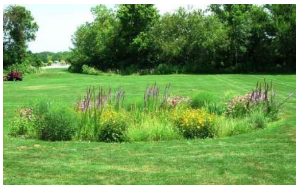
Figura 4.58 Sistema de biorretenção ao nível residencial (This Old House, 2014)
