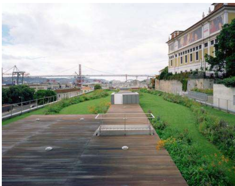
Figura 4.46 Cobertura verde da sede do Banco Mais, Lisboa (Gonçalo Byrne Arquitectos, s.d.)
