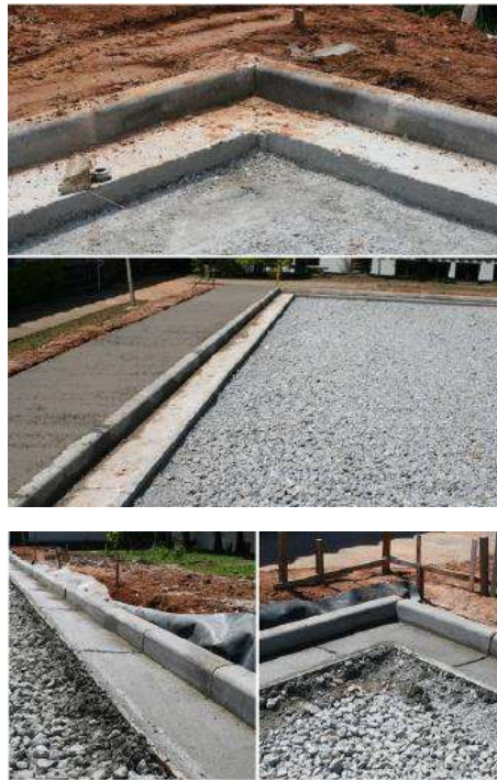
Figura IV. 9 Fase 9 Construção de Pavimento Permeável (Virgiliis, 2009)
