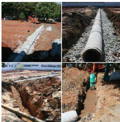
Figura IV. 4 Fase 4 Construção de Pavimento Permeável (Virgiliis, 2009)
