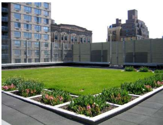
Figura 4.51 Cobertura semi-intensiva instalada numa escola em Manhattan, onde há uma separação nítida entre as zonas extensiva e intensiva (Castelo-Branco, 2012)
