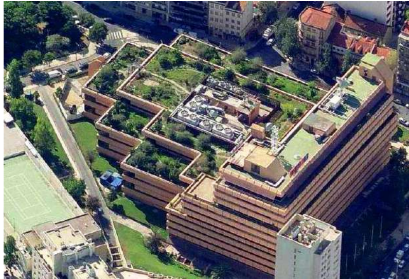
Figura 4.43 Vista aérea da cobertura verde do edifício da Portugal Telecom em Picoas (Costa, 2010)
