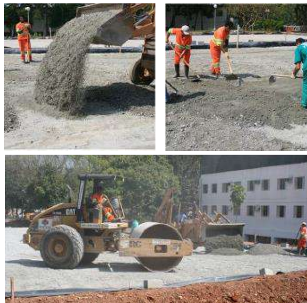
Figura IV. 8 Fase 8 Construção de Pavimento Permeável (Virgiliis, 2009)
