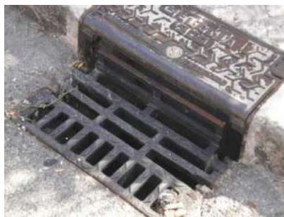
Figura 2.4 Combinação de sumidouro com sarjeta de passeio (Imagem cedida por Joaquim Sousa)
